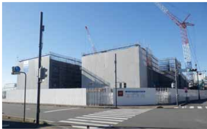
新市立高校建設工事
