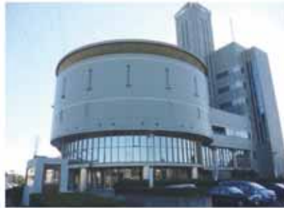
先進技術の導入で各支所機能の充実を(写真は鳩ヶ谷庁舎)
